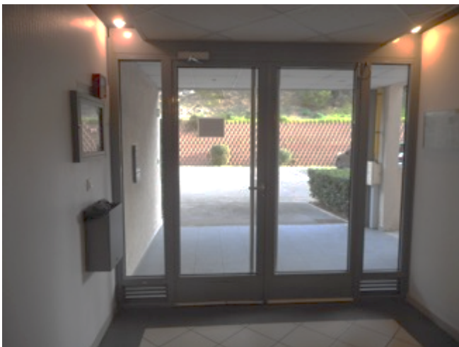
Porte d'entrée de l'immeuble
