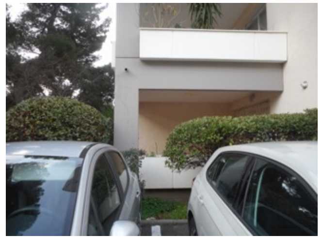
Vue sur le balcon depuis le parking
